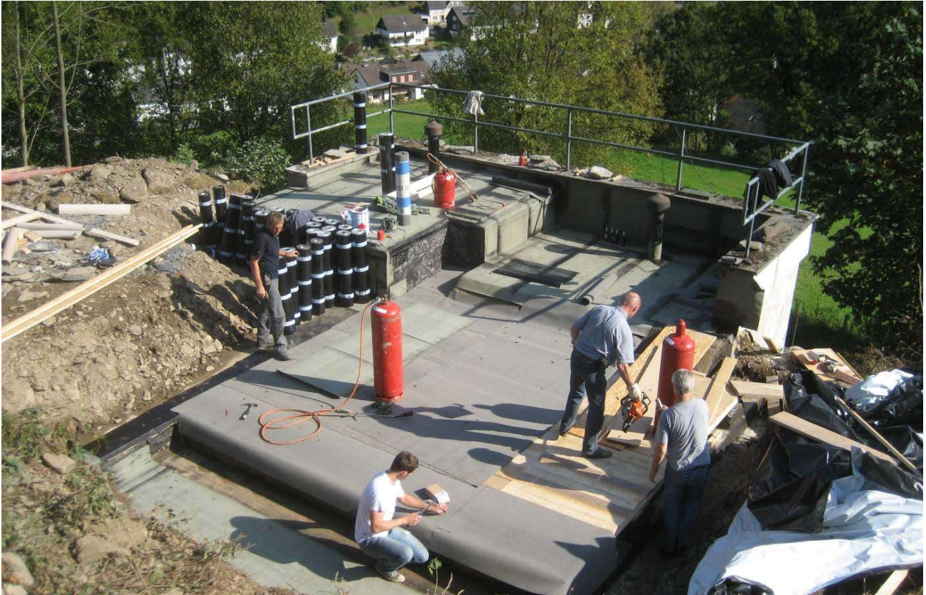
Aufgrund notwendiger Erneuerung der äußeren Abdeckung des Hochbehälters musste der Behälter 2009 freigelegt werden.
