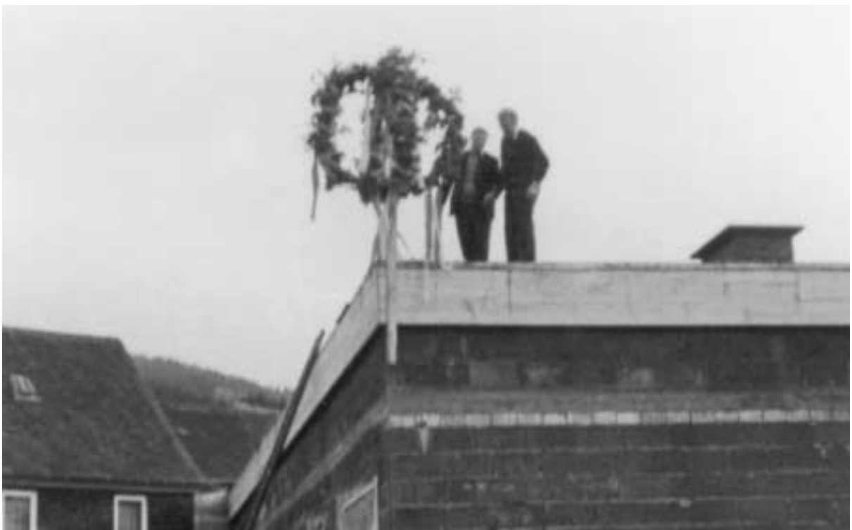
Richtfest nach dem Wiederaufbau im Herbst 1974, Günter Fischer, August Lange
