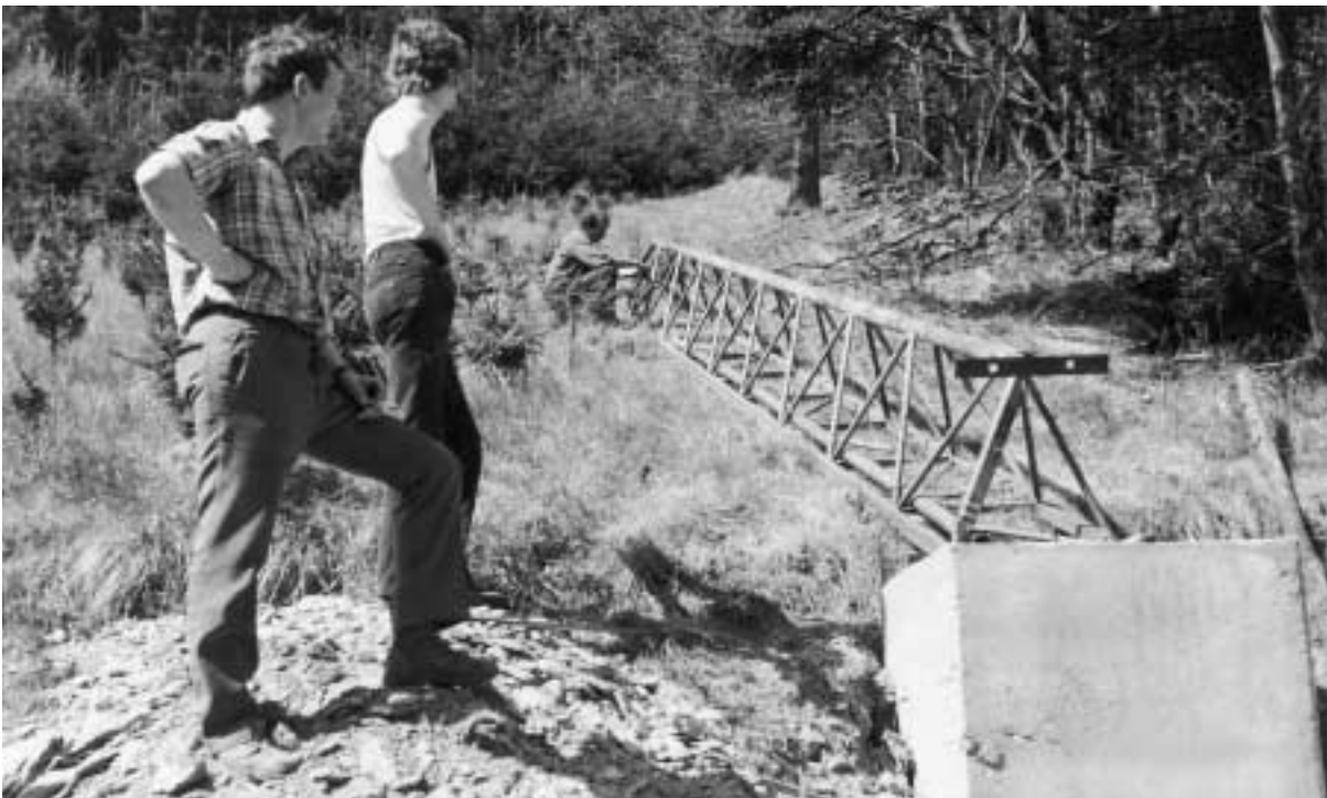
Errichtung des Antennenmastes der Rundfunk- und Fernsehanlage in Hundesossen am 15.5.1976. Im Bild von links: Alfons Rickert, Gottfried Schmidt, Karl-Josef Stilper
