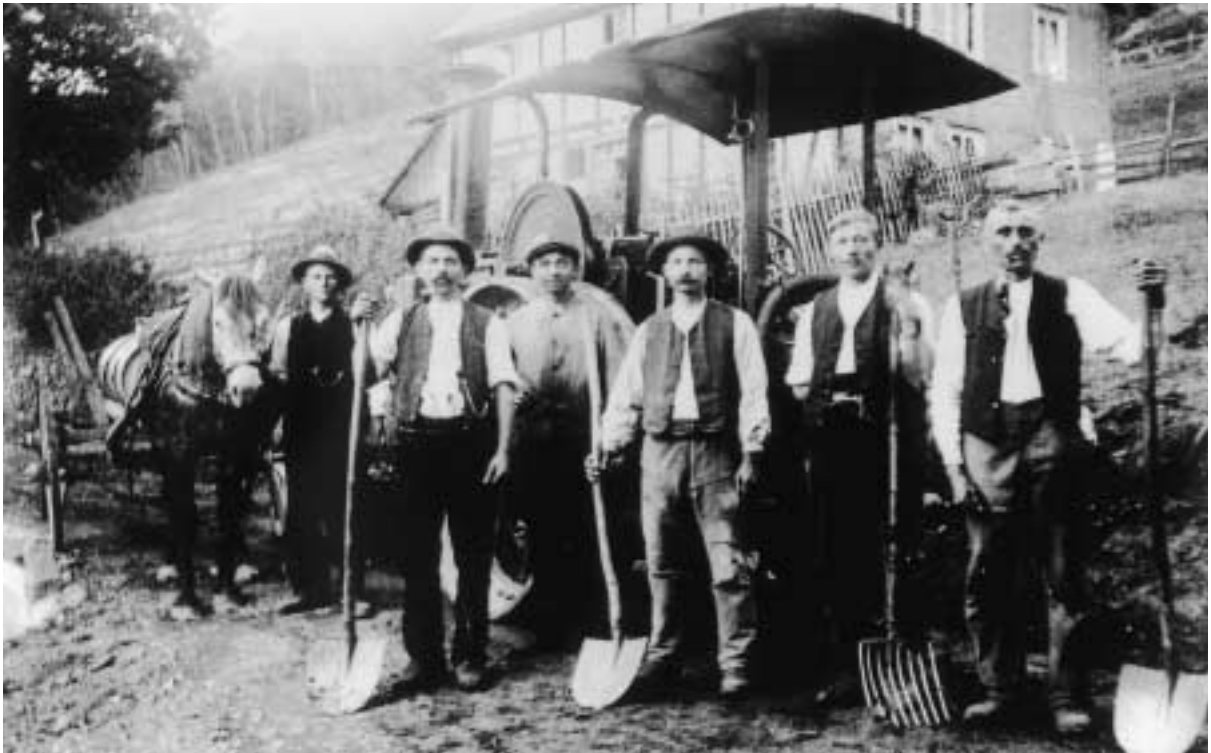
Aufbringung einer wassergebundenen Fahrbahndecke auf die Dorfstraße in Hundesossen, 1911
