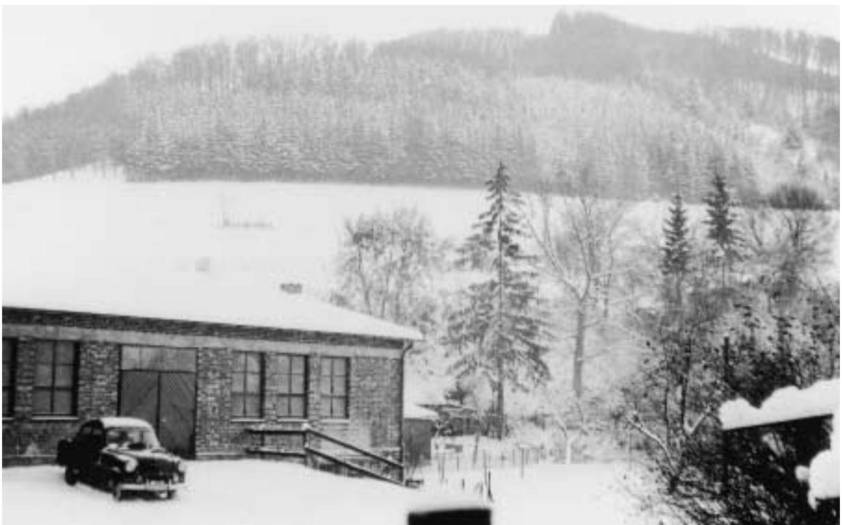
Anbau des neuen Hallenteils, 1955
