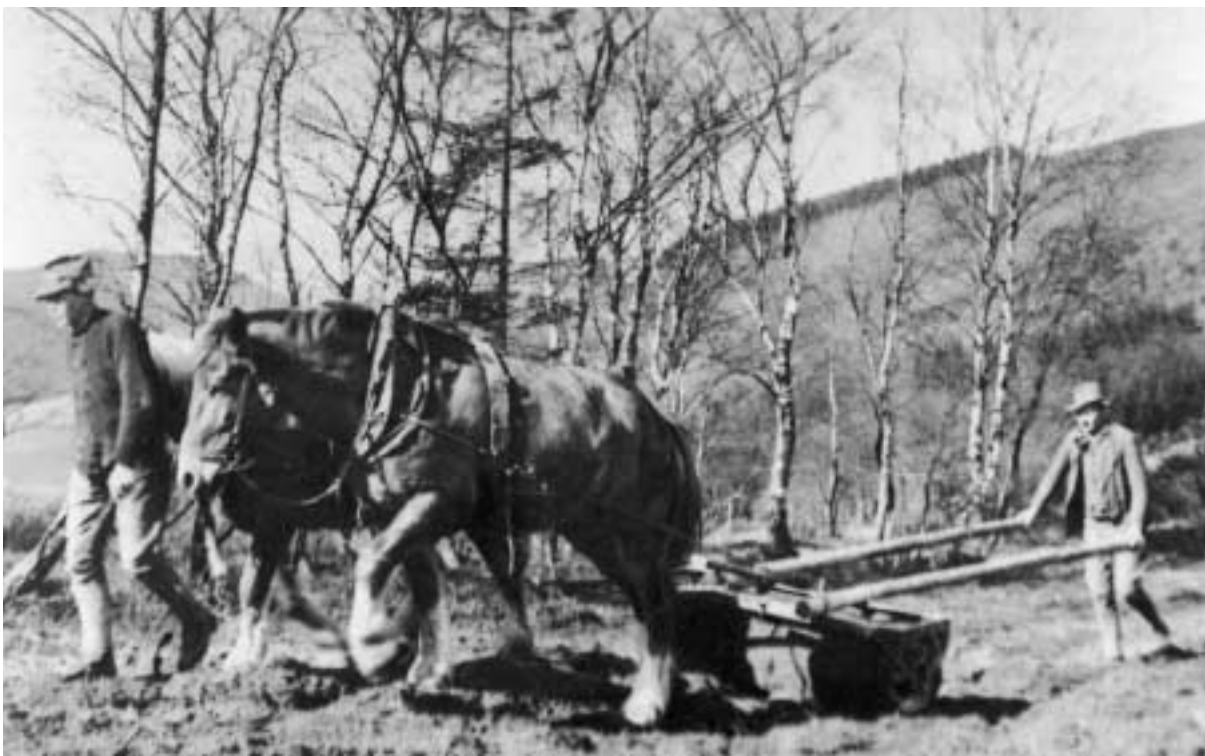
Sportplatzbau auf dem Kähling, 1938, Ferdinand Tröster, Milchenbach, Clemens Heimes, Hundesossen
