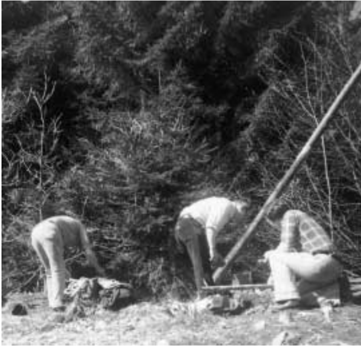
Verankerung der obersten Kopfstation, 1978
