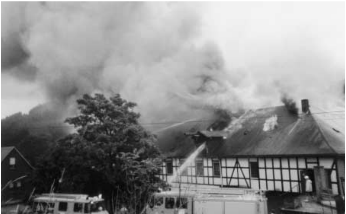
Brand der Fabrik Sternberg am 10.7.1990
