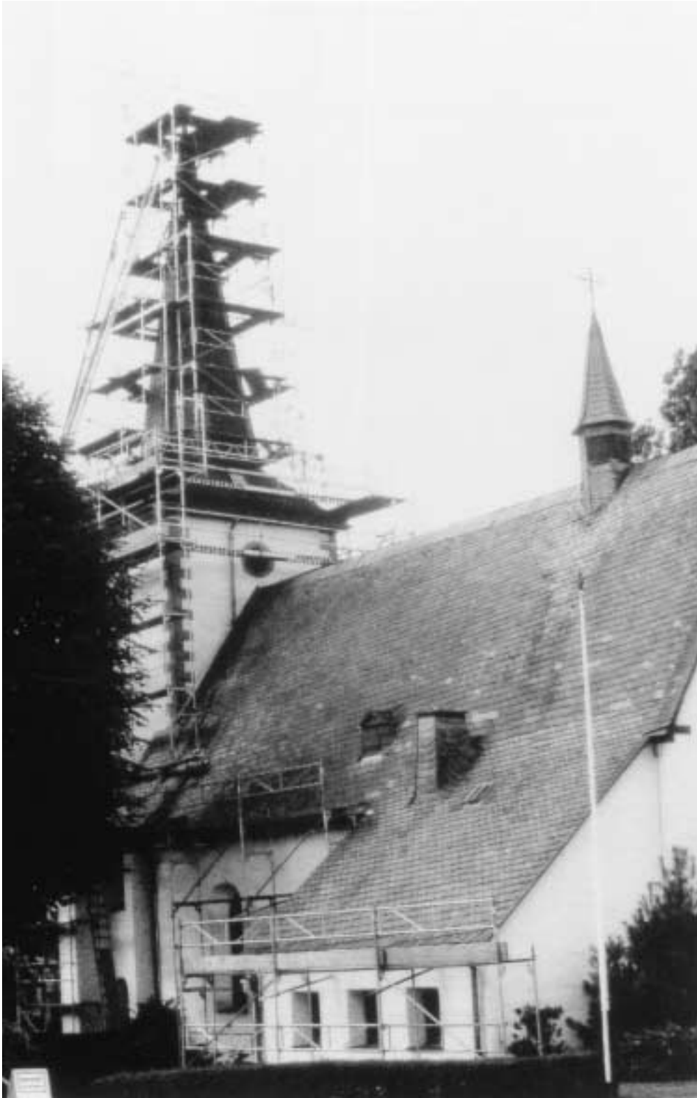
Renovierung des Kirchturms, 1985
